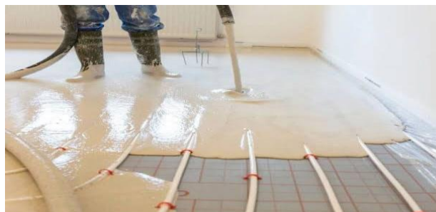
Figure I.8 : Mortier utilisé dans Les chapes
