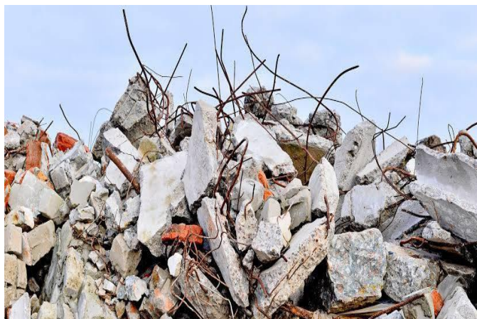
Figure I.47 : Déchets du bâtiment
