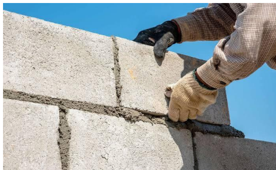
Figure I.6 : Mortier utilisé dans le hourdage de maçonnerie
