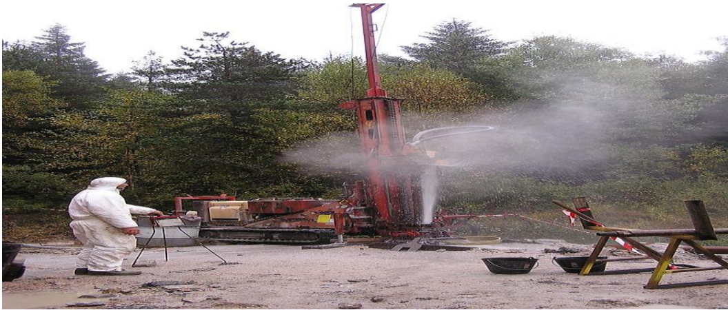
Figure1-1 : Forage vertical pour trouver de l'eau
