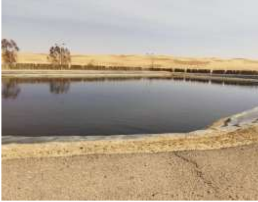
Photo N°10: Bassin de finition
