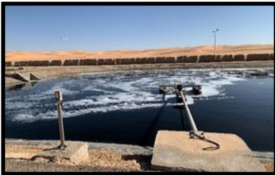
Photo 06 : Bassin d'aération A
