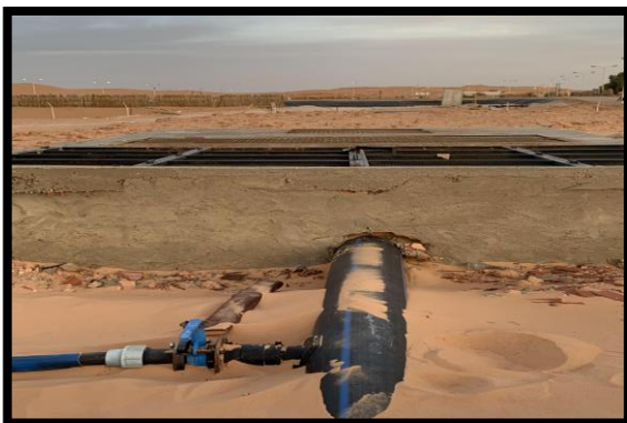
Photo 10 : Sortie des eaux
