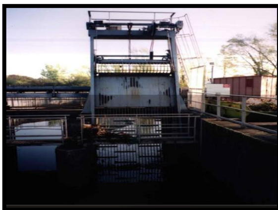
Figure I.6 : Grilles droites à nettoyage alternatif
