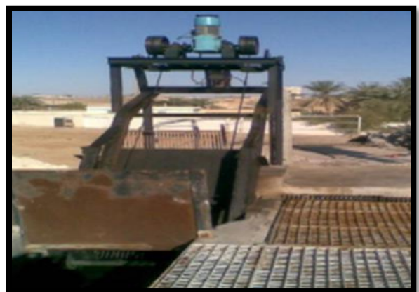
Figure I.7 : Grilles droites à nettoyage continu
