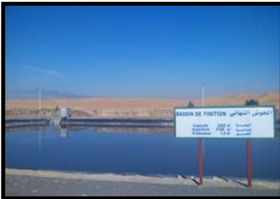
Photo 08 : Bassin de finition
