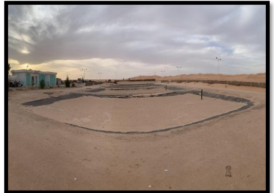
Photo 09 : Lit de séchage
