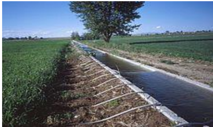
Figure II.1 Alimentation des planches par siphon
