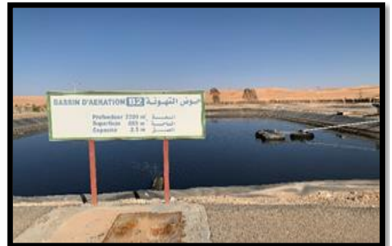
Photo 07 : Bassin d'aération B
