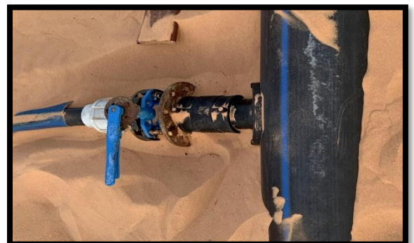
Photo 21 : Raccordement des conduites
