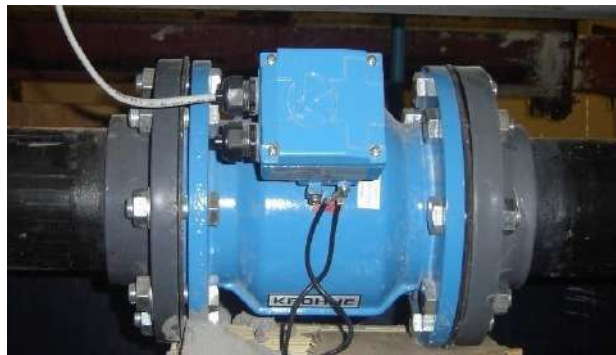
Figure 4.11: Capteur de mesures des débits.
