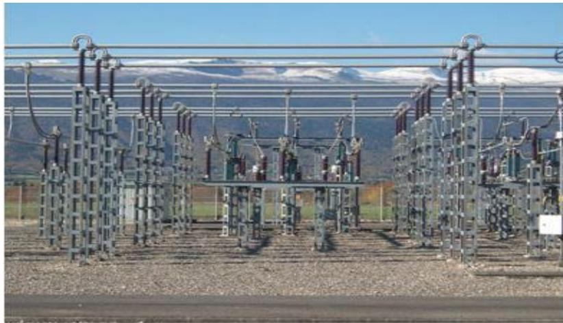
**Figure II.7:** Jeux de barres de puissance
