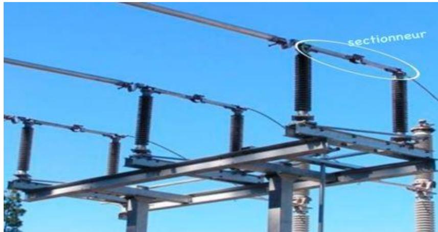
**Figure II.4:** Sectionneur
