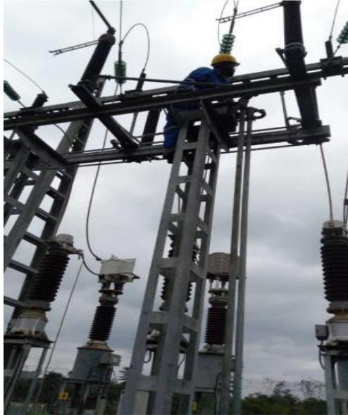
**Figure II.32:** Maintenance préventive des sectionneurs
