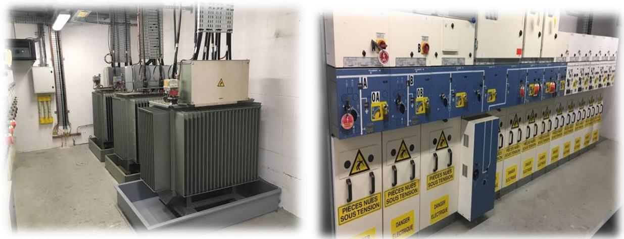
**Figure II.11:** Les cellules et Transformateur des SST
