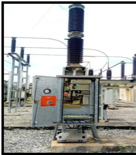
**Figure II.31:** Maintenance des disjoncteurs
