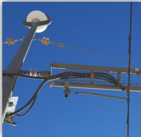
**Figure II.21:** Point d'injection sur la LAC (nourrice)
