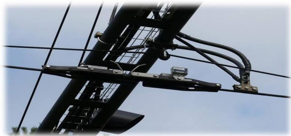
**Figure II.22:** Isolateur de section
