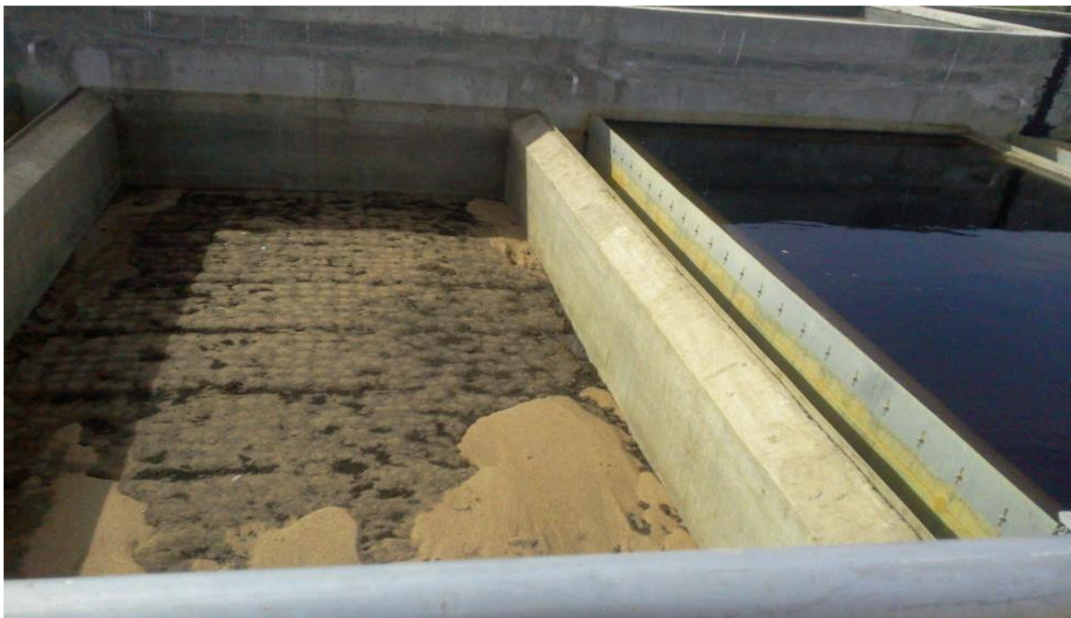
Figure II.2. Le filtre à sable
