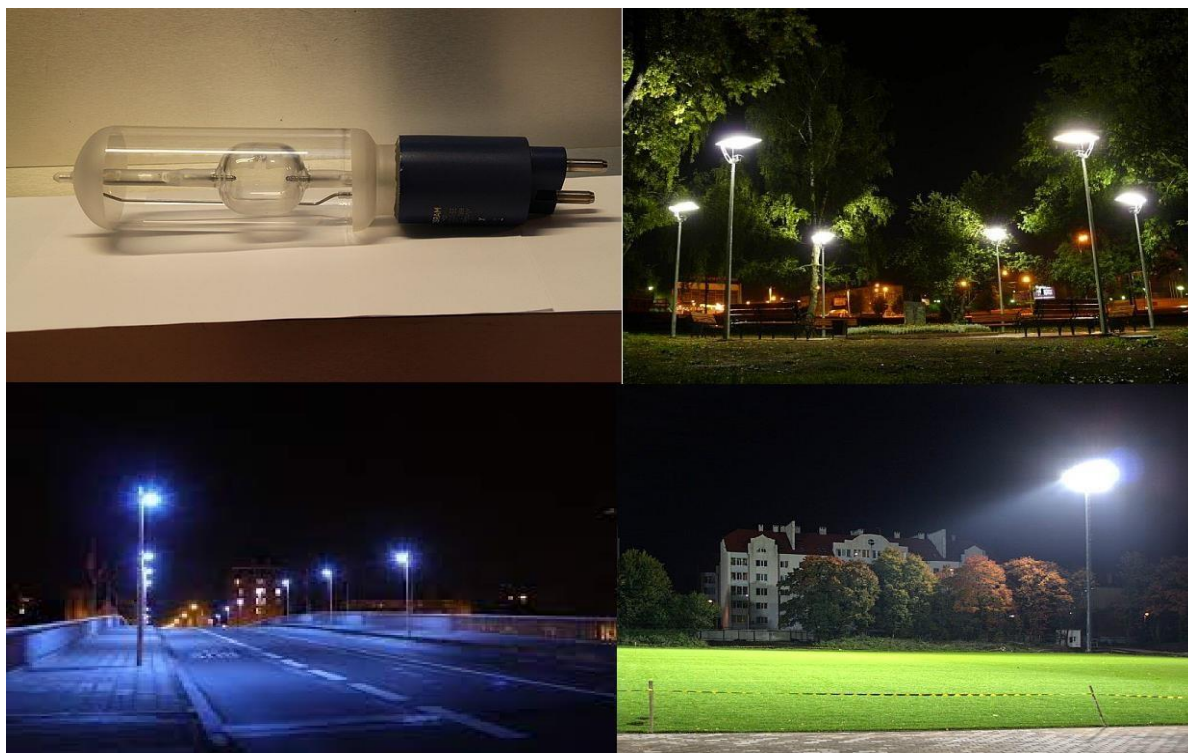
Figure II. 3 Lampes fluorescentes à tube dans l'éclairage public.
