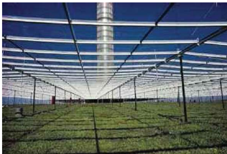
FIGURE II.1 – Vue intérieure du Collecteur de cheminée solaire
