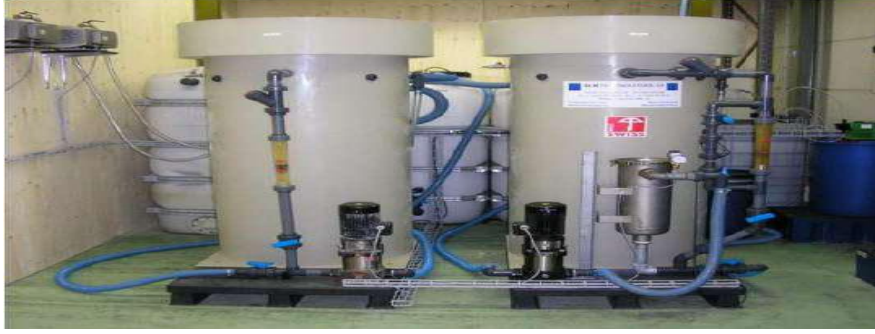
الشكل 2. 4: محطة إزالة الحديد بيولوجيا
