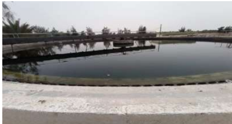
I.8.Photo. Les bassins de décantation secondaire
