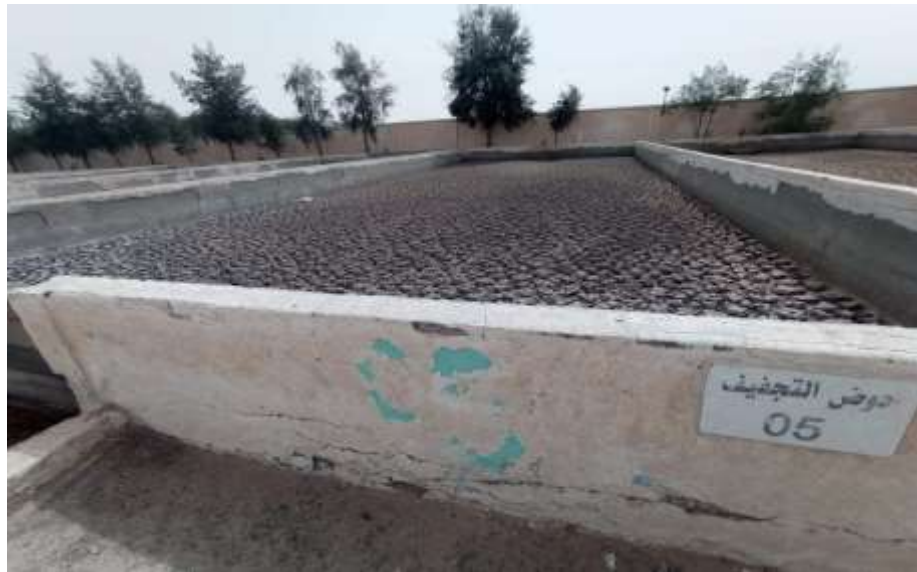
I.6.Photos: bassin de sédimentation (photographie original)
