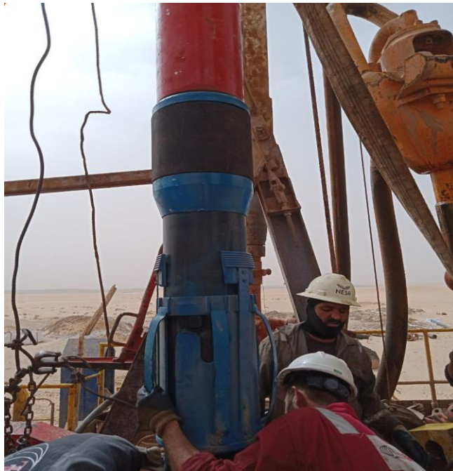
Figure N° 33 : Liner Hanger Packer
