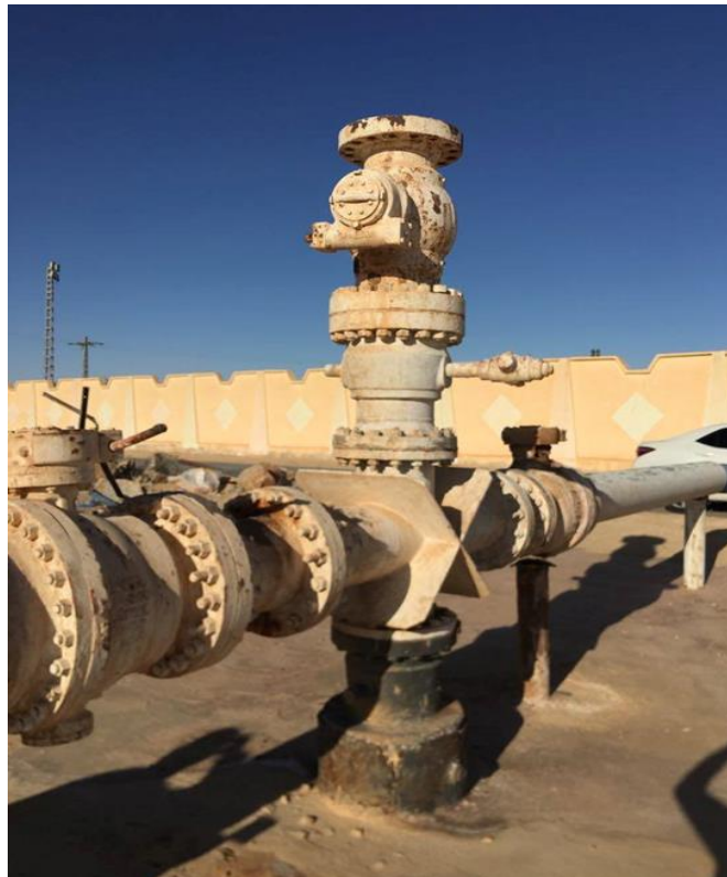
Figure N° 34 : tête de puits.
