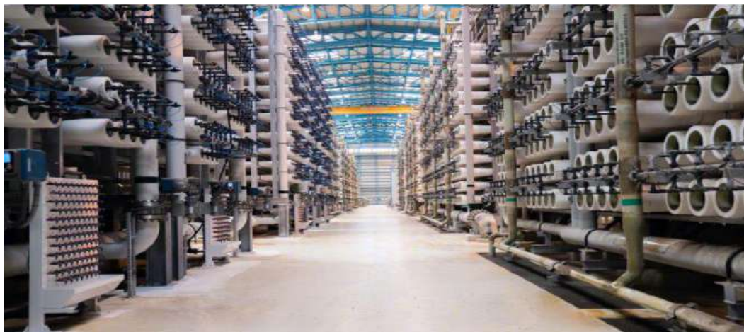
الشكل III-7: وحدة تحلية مياه البحر الأنبوبية داخل محطة تحلية مياه البحر. يتم وضع أغشية التناضح العكسي في داخل هذه الوحدة ، وتقوم هذه الأغشية بفصل الملح عن مياه البحر.
