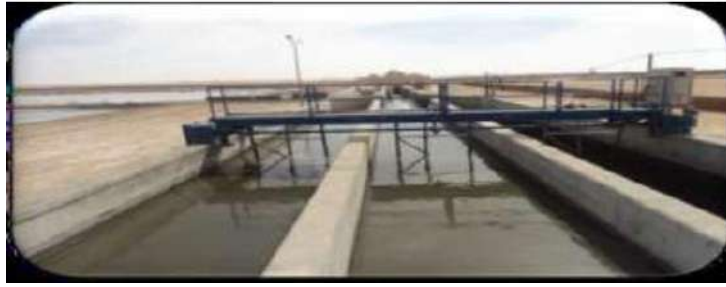
Figure (III.05) : Dessableur dans la station d'Ouargla
