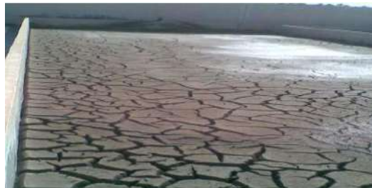
Figure (III.27): Lits de séchage dans la station de Touggourt
