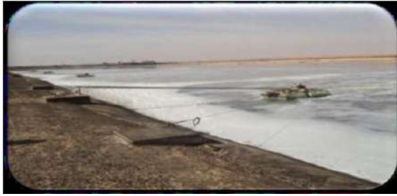
Figure ( III.06): Lagune d'aération dans la station d'Ouargla
