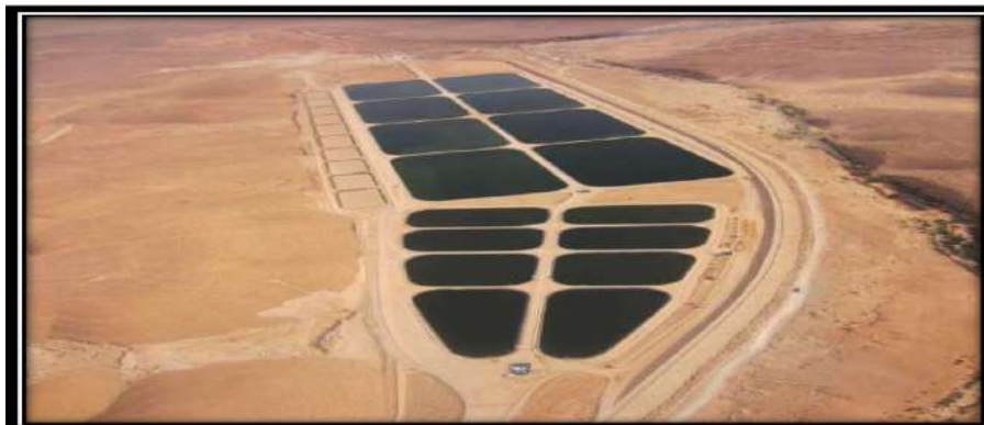
Figure (III.10): Vue aérienne de la STEP de Ghardaïa
