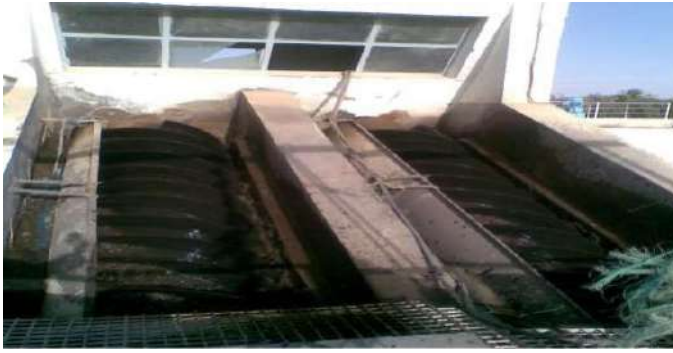
Figure ( III.25) : Vis d'Archimède dans la station de Touggourt
