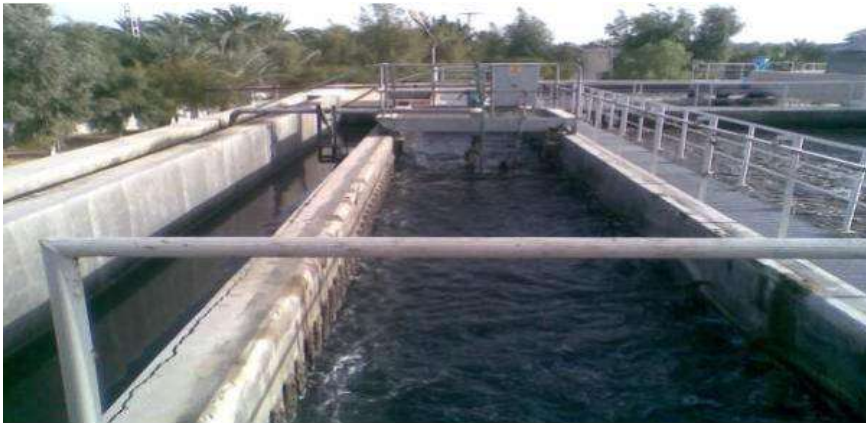
Figure (III.21) : Dessablage-déshuilage dans la station de Touggourt
