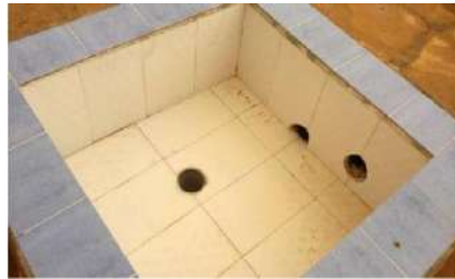
Figure (III.35): Boîtier de contrôle
