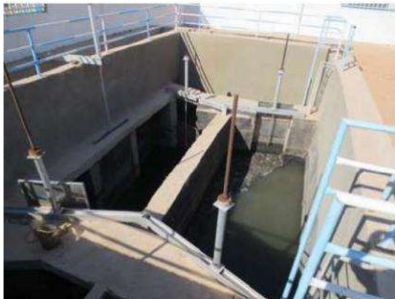
Figure (III.13): Bassins de décantation et de sédimentation sableuse
