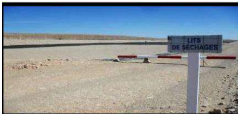
Figure (III.16): Photo d'un lit de déshydratation des boues
