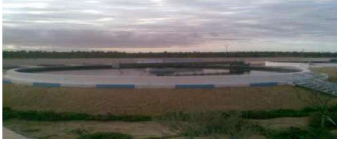
Figure (III.23): Décanteur secondaire dans la station de Touggourt
