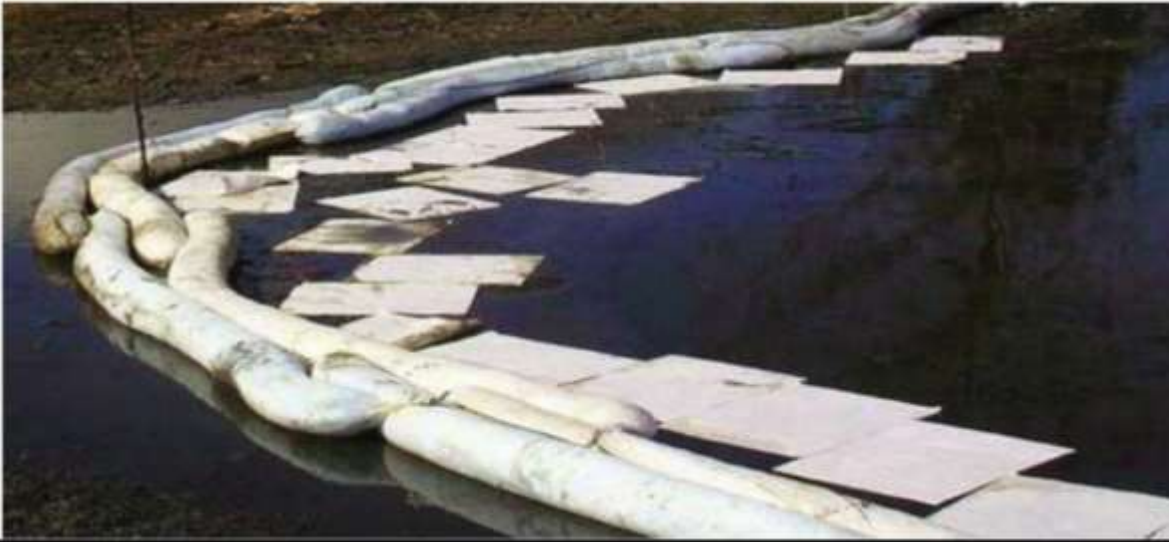
الشكل (16): نشر الضمادات الماصة على السطح لتجميع الانسكاب.
