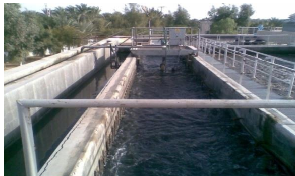
الشكل (4.III):صورة توضح عملية نزع الأتربة و الزيوت
