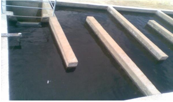
الشكل (6.III): صورة توضح حوض الكلورير
