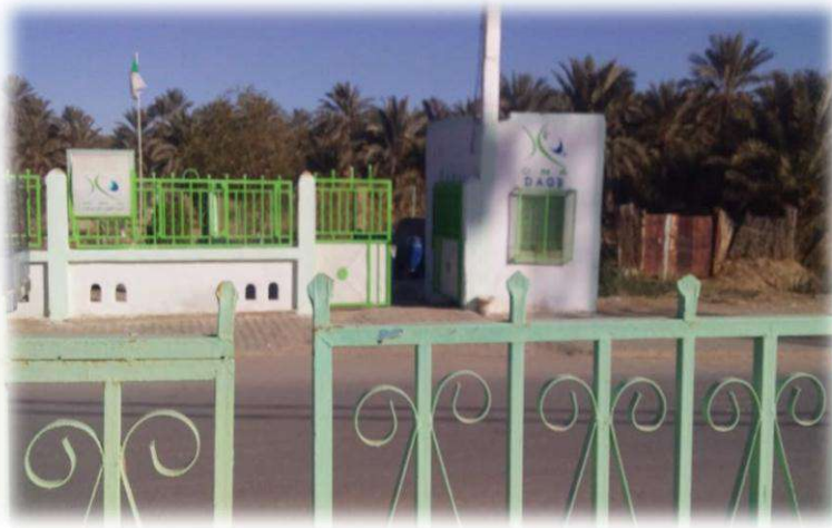
الصورة رقم (14): صورة توضح محطة التصفية بتماسين
