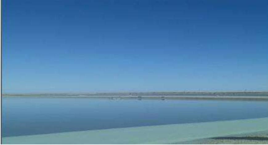
الشكل رقم(3): صورة توضح محطة التصفية بالبحيرات
