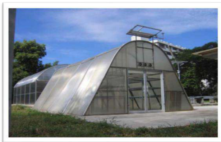
Figure I.13 : Séchoirs solaires de type serre [Janjai et al ]
