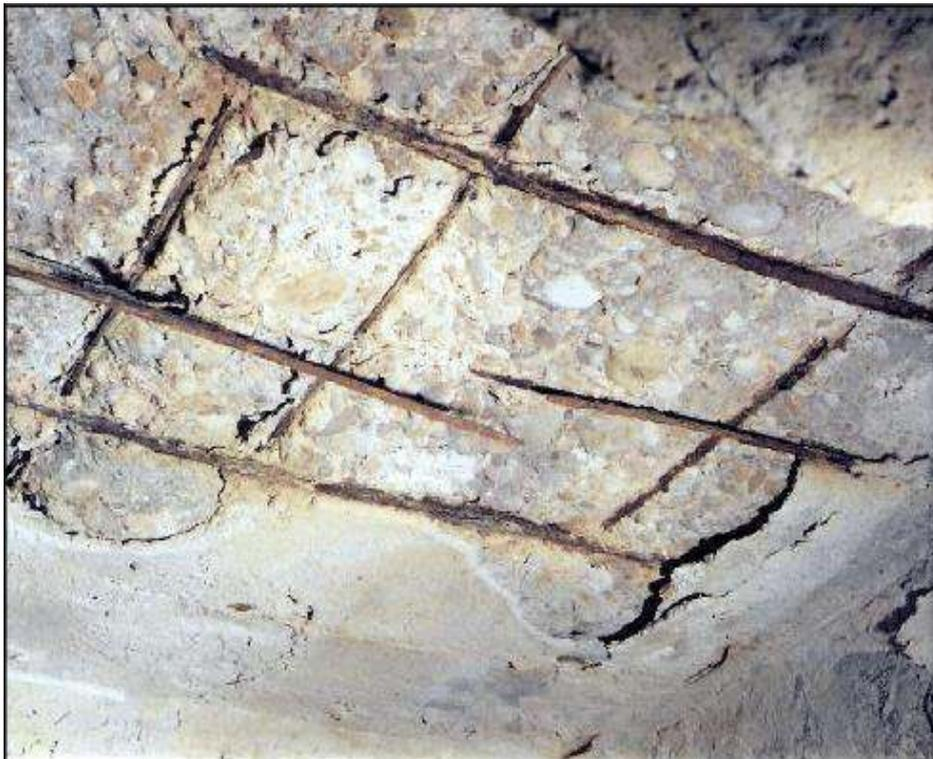
**Figure I.2 : La dégradation par la corrosion des armatures [7].**
