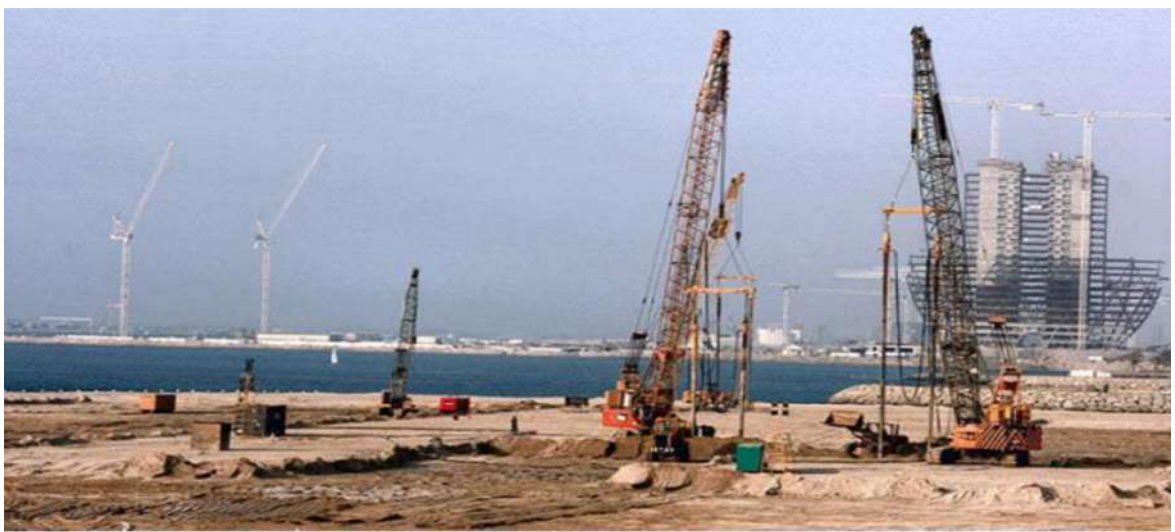
Figure. I.4 : Vibrocompactage.
