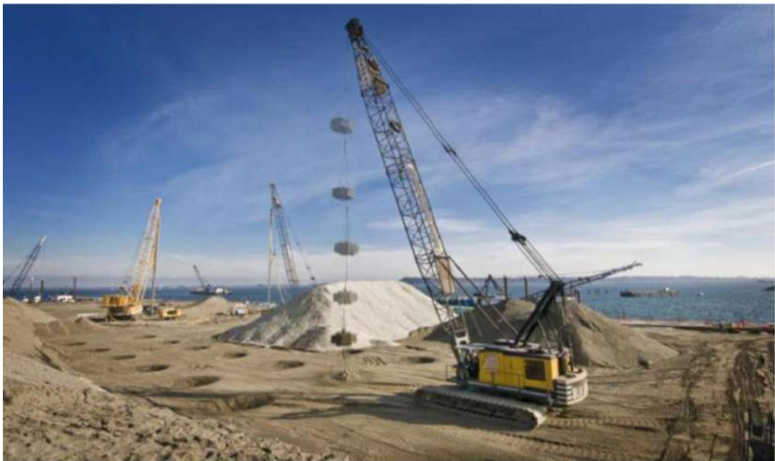
Figure .I.3 : Chantier d'un compactage dynamique profond
