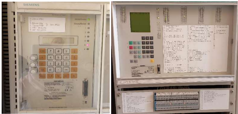
Figure II.12 Relais différentiel numérique-GRTE Quartier Hassi Messaoud.
