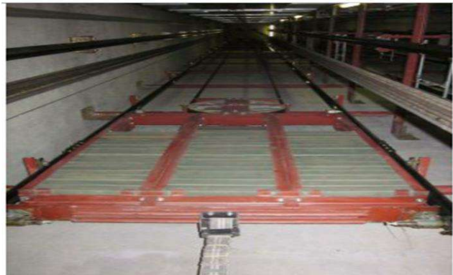
Figure I-14 : Le contre poids [27].
