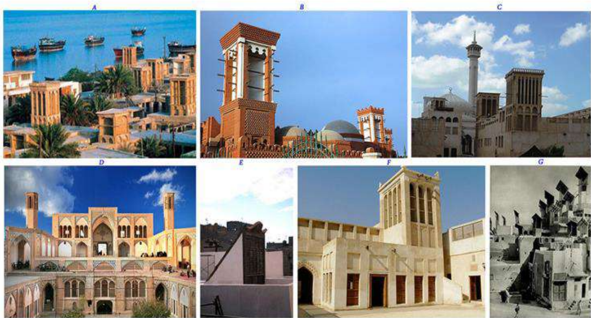
Figure I.12 : Différents tours à vent traditionnels au Moyen-Orient : (A) Badgir dans le climat chaud et humide de l'Iran ; (B) Barjeel décoratif au Qatar ; (C) Barjeel dans le quartier Bastakiya de Dubaï ; (D) Badgir dans le climat chaud et sec de l'Iran ; (E) Malqaf en Egypte ; (F) Barjeel à Bahreïn ; (G) Mungh au Pakistan [38,47].
