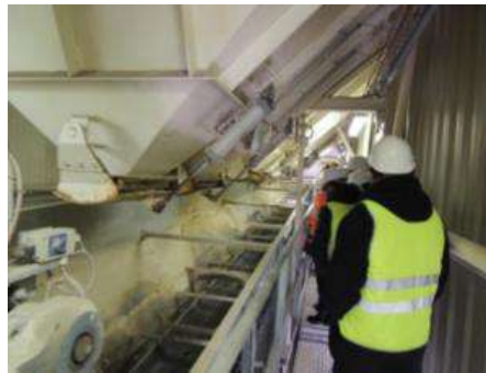
Photo 1.6 : Dosage des granulats par tapis peseur.
