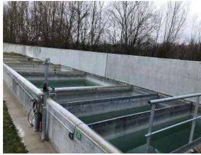
Photo 1.5 : Bassins de décantation pour l'eau recyclée
