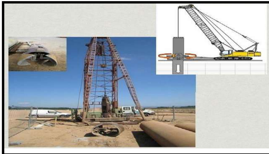
Figure 11 : Sonde de forage par Battage.
