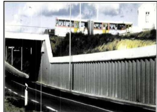
Figure I.3 :Ouvrage de soutènement terrestre en palplanches
