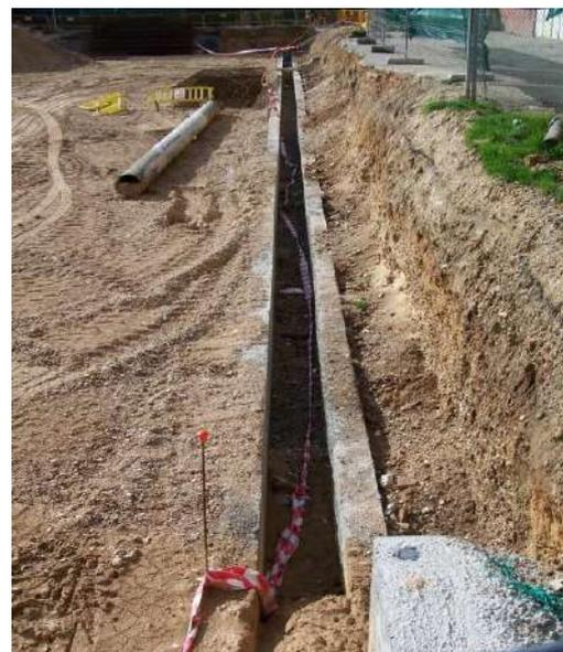
**Figure II.3:** Murettes-guide pour l'exécution des parois moulées.
