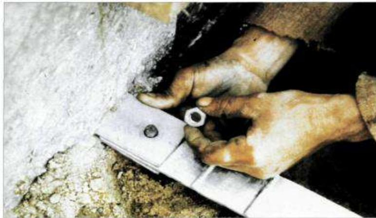
Figure I.12 : Renforcement par lanières métalliques de terre armée
