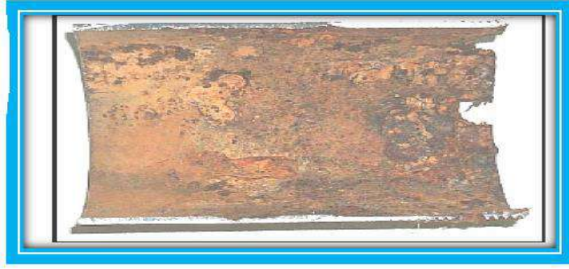
الشكل (1-3): صورة للتآكل الغلفاني [6]
