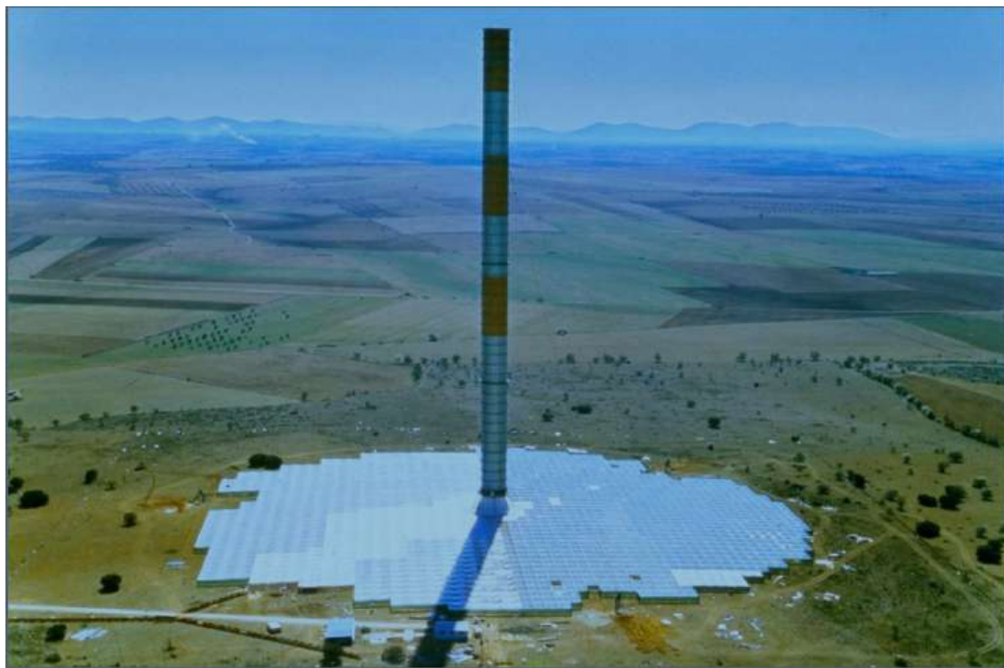
FIGURE 3.21 – Installation d'essai de cheminée solaire de Manzanares, établie en 1982-1983 en Espagne.
