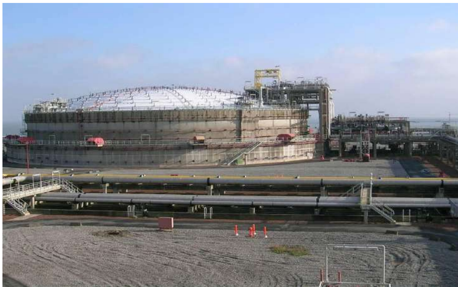
Figure I.16: Réservoir semi-enterré à Zeebrugge – Belgique [20]
