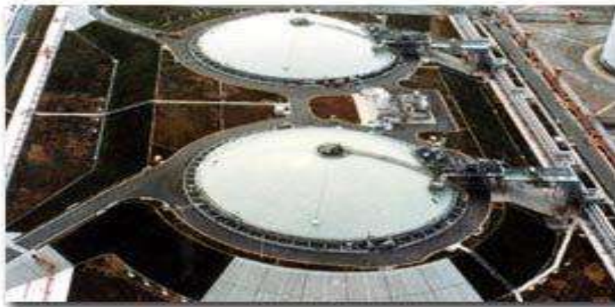
Figure I.14: Exemple de réservoirs à membrane semi-enterrés [21]
