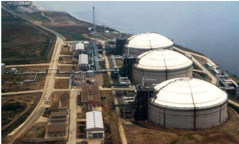
Figure I.7: Exemple de réservoirs à double intégrité [ 2 0 ]
