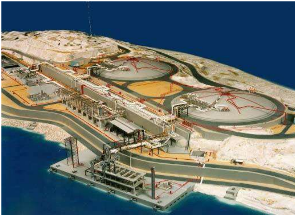
Figure I.18 : Réservoirs du terminal de Revithousa en Grèce [20]
