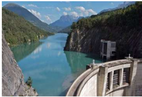
Figure 1. 18 Barrage hydraulique d'une centrale hydroélectrique
