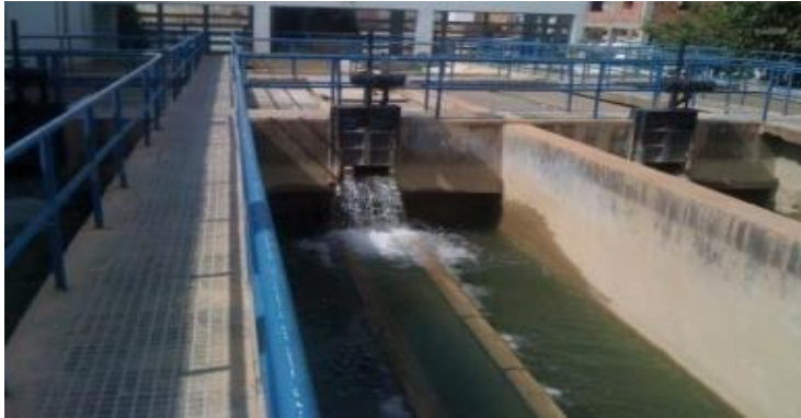
Figure III-09 : Le bassin de filtration.
