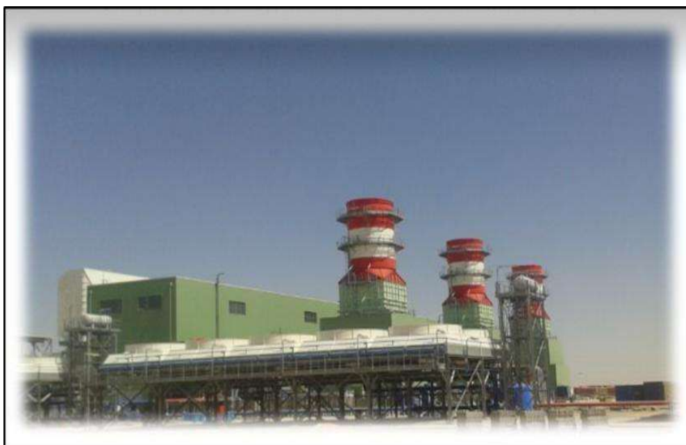
Figure I.6: Trois groupes turbine gaz
