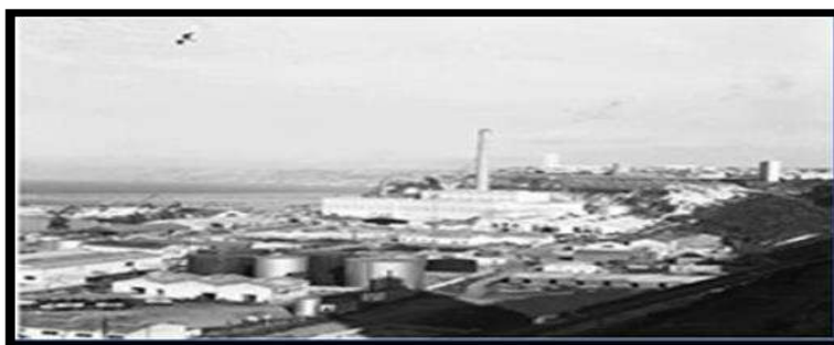
Figure I.2: la première centrale thermique de MARSA EL KABIR –Oran [2]
