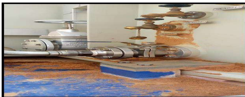
Figure III.2 : La vanne d'échantillonnage
