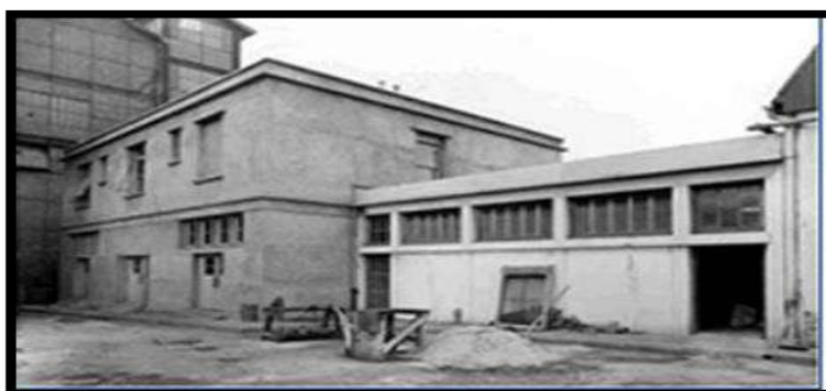
Figure I.3: centrale EL HAMMA d'une puissance installé de 64 MW [2]
