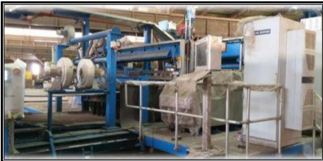
Figure 17: Partie De Vérification De Métal
