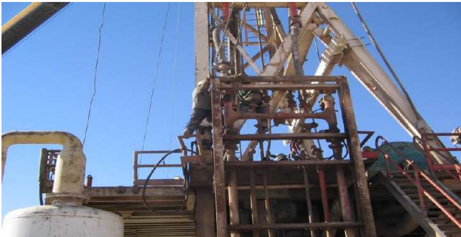
Figure (5): Phase démontage d'un appareil de forage.
