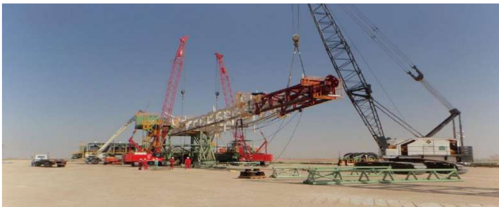
Figure (11): Descente de mât
