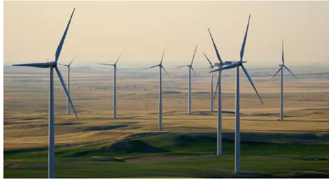
Figure. I. 3. Un champ d'énergie éolienne
