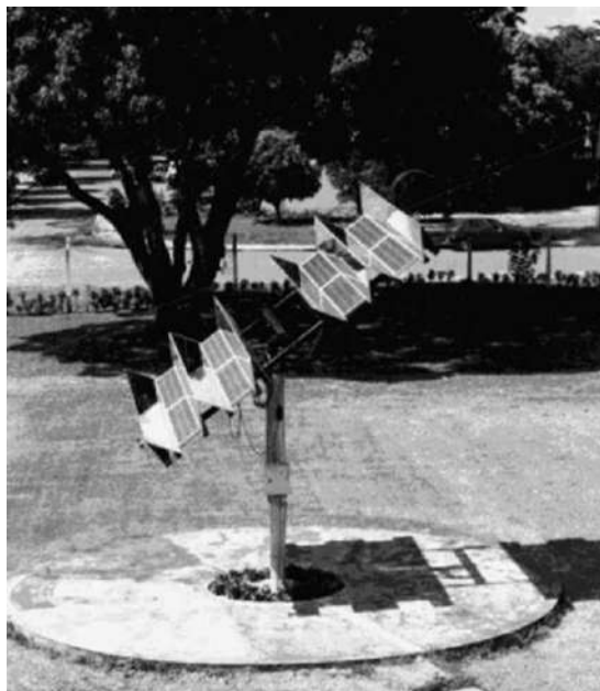
Figure I.26. Vue globale du système traqueur-panneau PV-deux réflecteurs en haut-bas [42]
