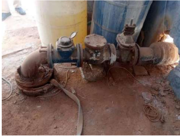
Figure II. 6: Forage de la piscine d'Ouargla
