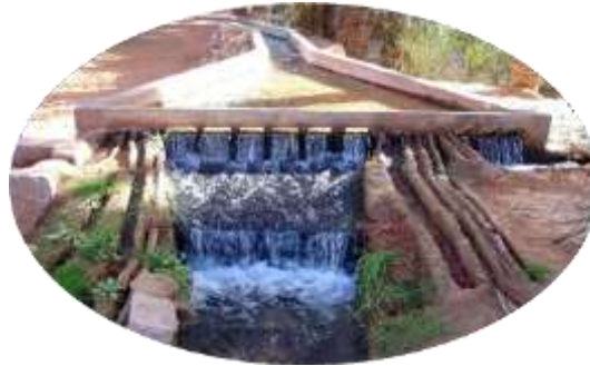
Photo 1- Foggara : système « séculaire » de captage et de partage d'eau.
