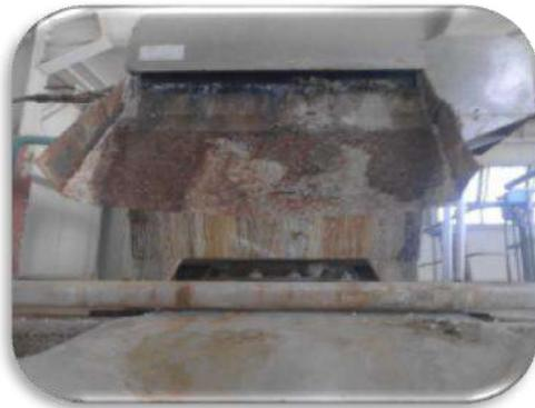
Figure III.10 : Dégrilleur[16].
