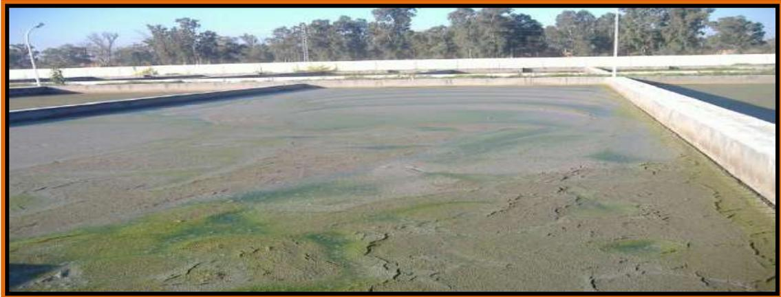
**Figure II.4 : Lit de séchage (boues liquides) [1].**
