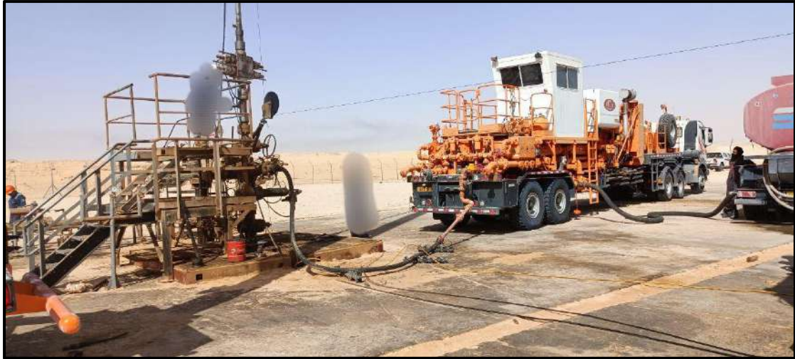
Figure A.II : injection d'eau à l'aide de l'unité bullheading au cours traitement de sel BRS-13
