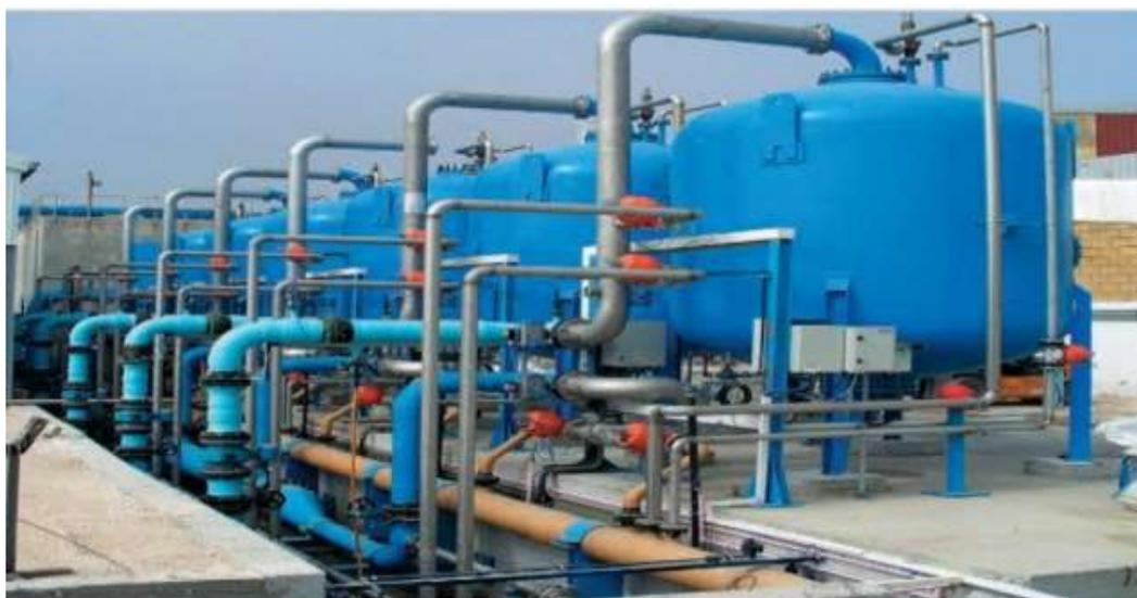
**Figure IV.13: les résines échangeuses d'ions en traitement d'eau [17].**
