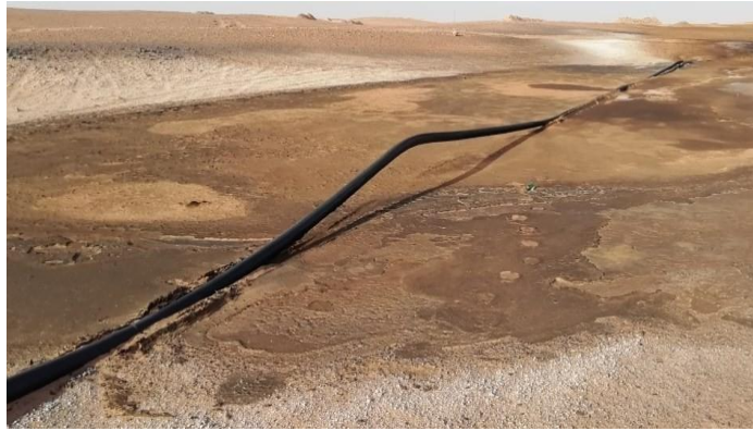
Figure.III.14.Ligne de torche du puits OKN # 721 [7]
