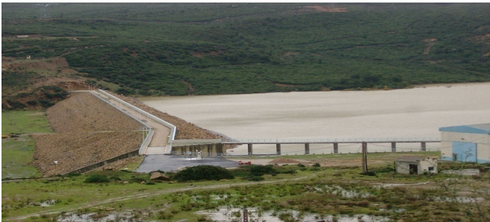
Fig.1. Retenue d'un barrage
