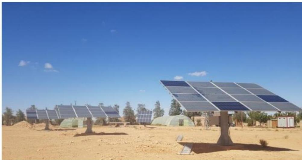
Figure 3 - 12 : Les trois champs portés par des structures suiveuses du soleil.
