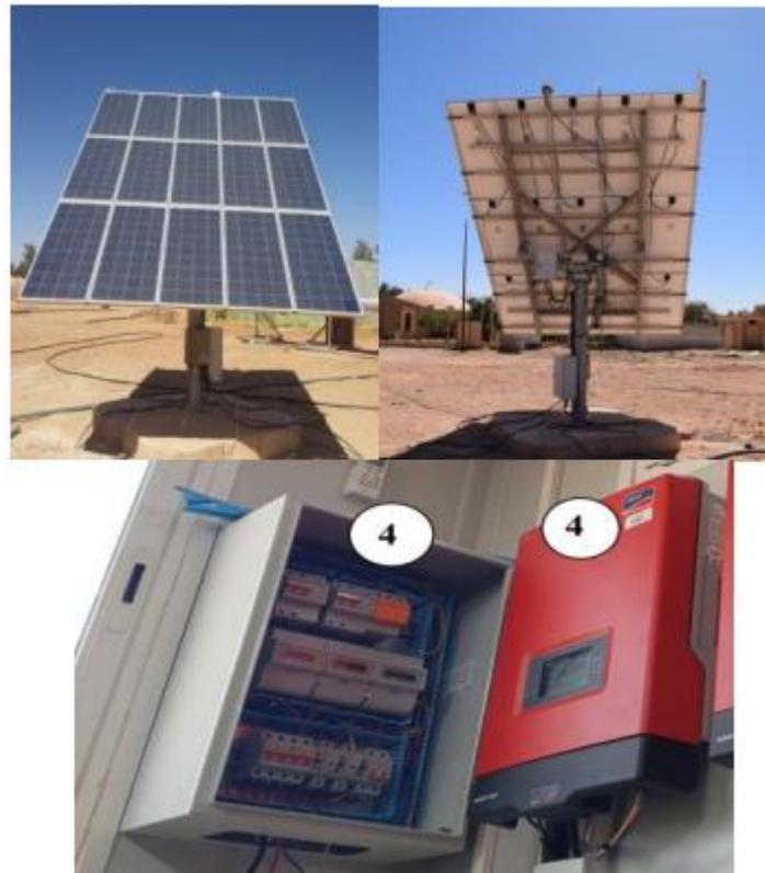
Figure 3 - 8 : Structure porteuse, champ PV, armoire électrique et onduleur.
