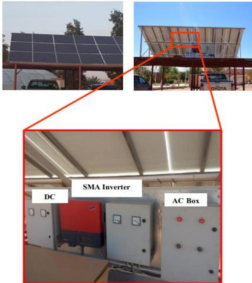
Figure 3 -5 la centrale montée sur le toit du parking , et les armoires électriques DC et AC ainsi que l'onduleur
