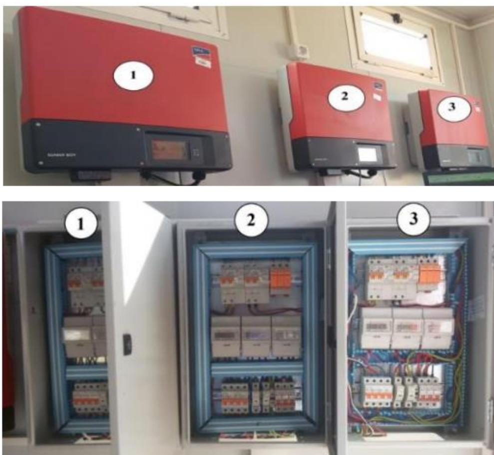
Figure 3 - 13 : Les onduleurs monophasés et leurs armoires électriques de connexion aux trois phases du réseau
