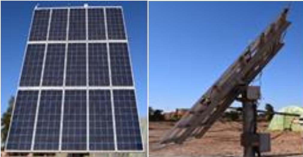
Figure 4- 1 : Système photovoltaïque monté sur suiveur réel du soleil.
