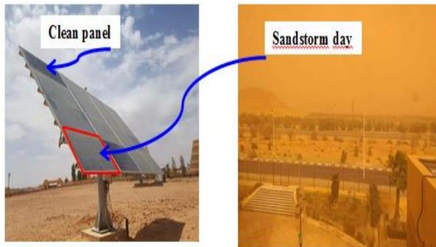
Figure 3 - 23 : influence des tempêtes de sables sur la surface de captation des champs PV
