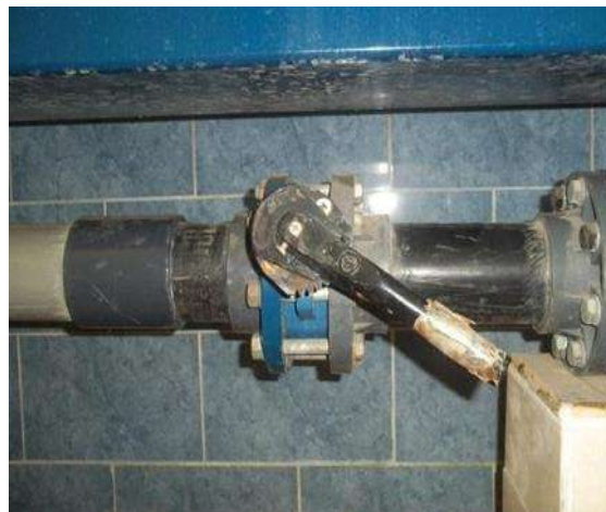
Photo2.4:vu de la vanne
