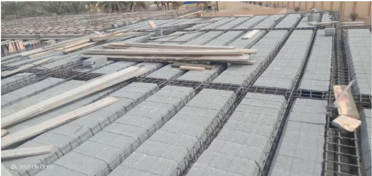
Figure I.1.1. Plancher à corps creux
