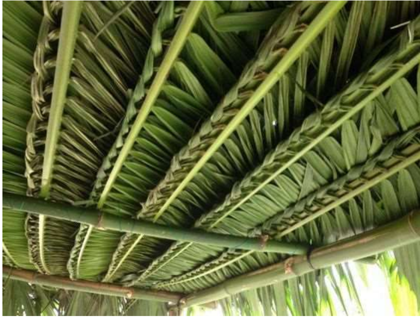
Figure 22 : Tressage de feuilles de palmier dattier pour la construction d'un abri.
