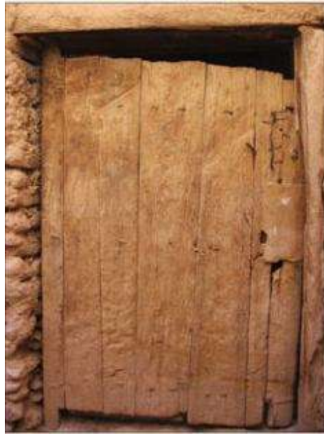
Figure 21 : Troncs de palmier dattier utilisés pour la fabrication de portes.
