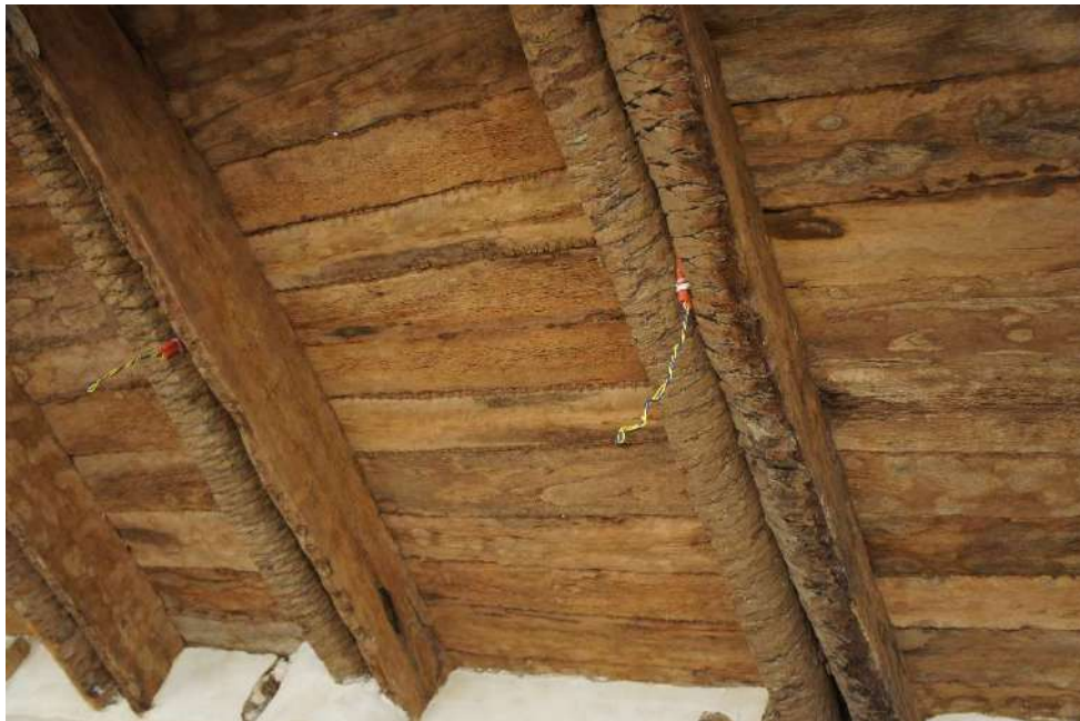
Figure 20 : Troncs de palmier utilisés pour la fabrication de toits.
