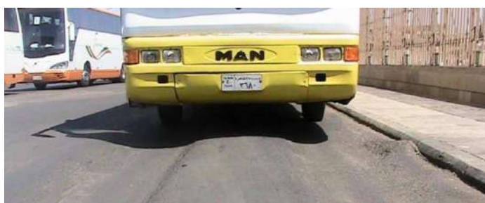
Photo IX.2. Orniérage superficiel.
