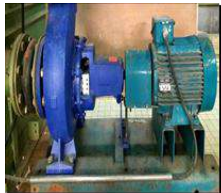
Photo 1.3 : vanne de réglage et pompe
