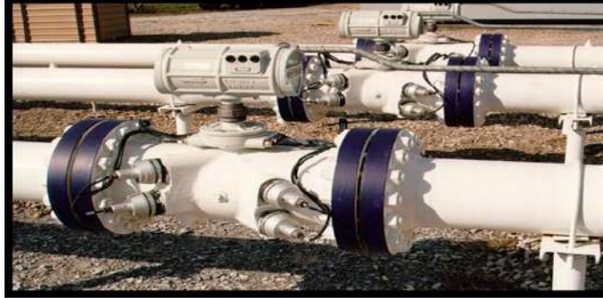
Figure 1-6 Compteur à ultrasons
